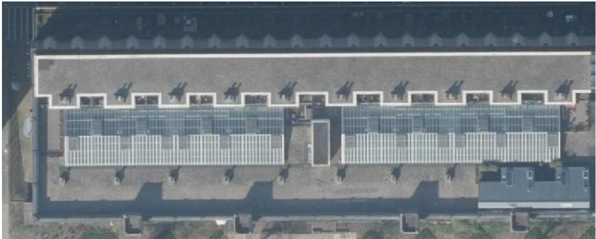
Luchtfoto van het dak (voorjaar 2022).
