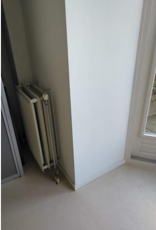
Foto: voorzetwand in de erker van een A-appartement.
